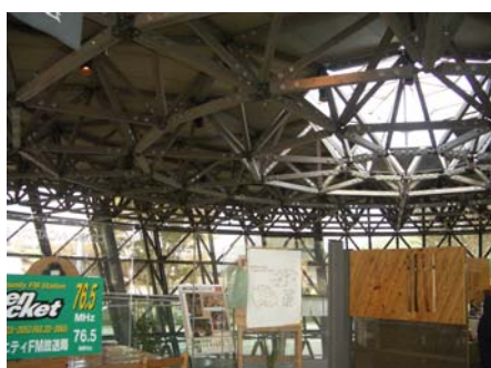
ゆうステーション内部
